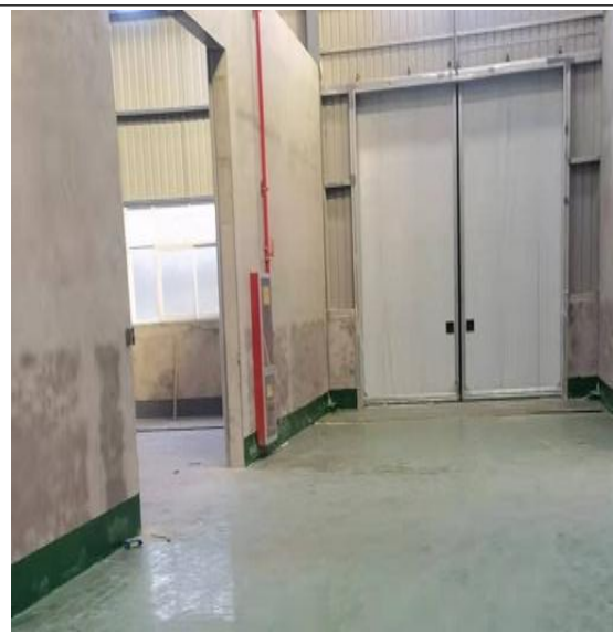
危废库房地面 2
