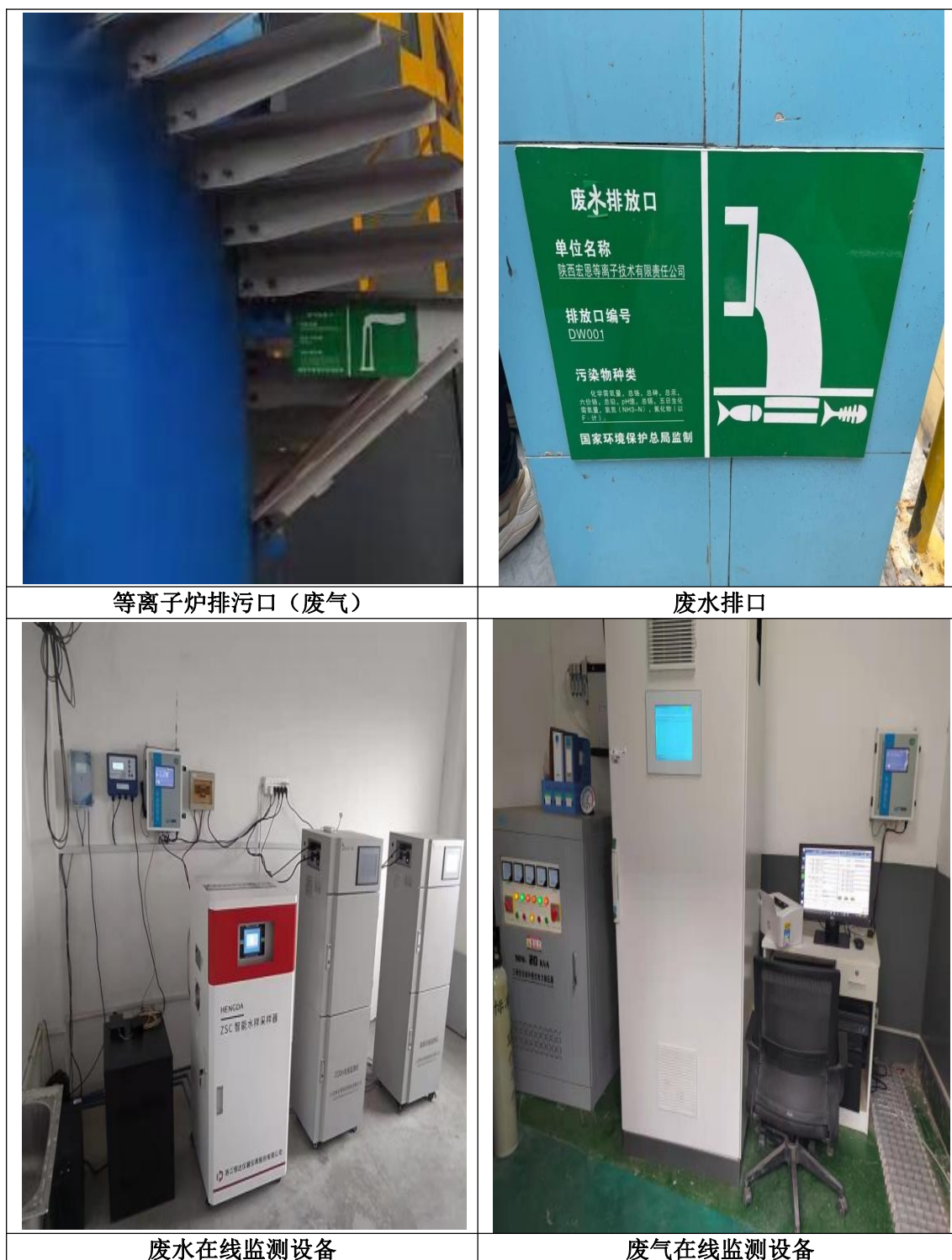
图 4.2-3 排污口规范化标识及在线监测仪器
