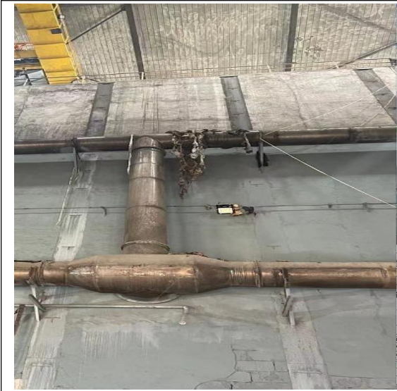
固体废物进料区域废气收集装置
